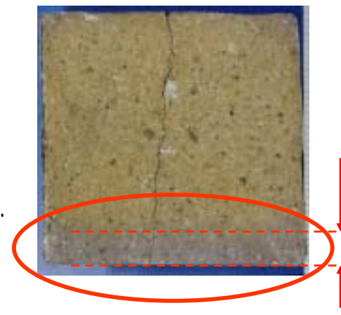
写真 - 11 塩化物イオン浸透深さ測定の例
